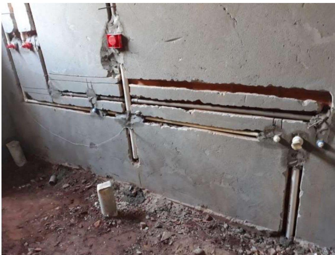
Figura 2 – Instalações de infraestrutura no método convencional.
